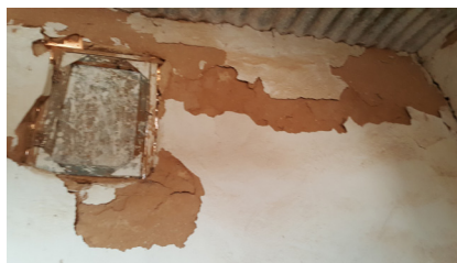
Finestra danneggiata dall'alluvione del 2017
